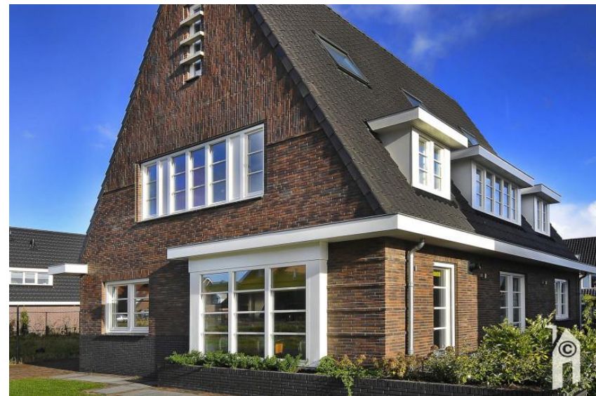
Jaren '30 typologie, metselwerkvolumes, uitgelaten vormen, rijke detailleringen.
