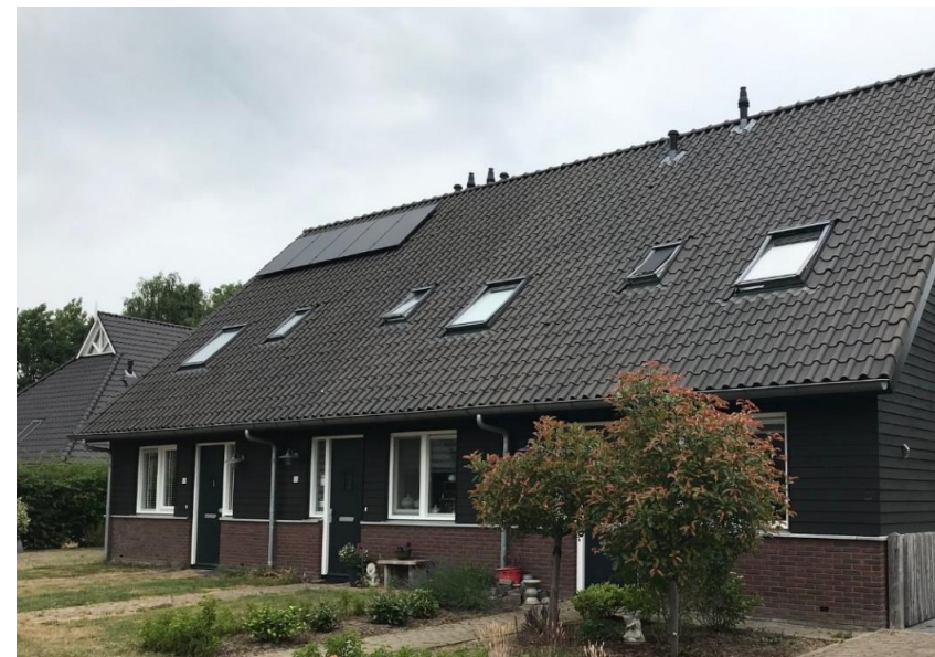
Rode ‘Drentse’ baksteen, schuurwoning typologie, pannendak, eenvoudige massa-volume verhouding.
