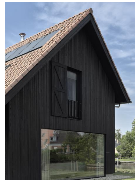
Enkelvoudige elementen zoals schoorstenen en dak overstekken. Incidenteel grote openingen
