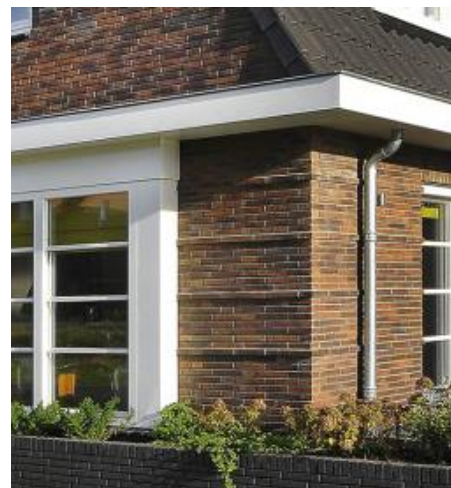
Horizontale belijning in metselwerk
